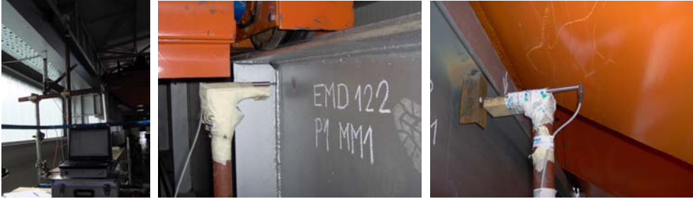
Slika 6. Postavljanje mjerne opreme
