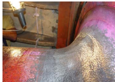
Slika 9. Izgled ispolirane površine pre AKZ
