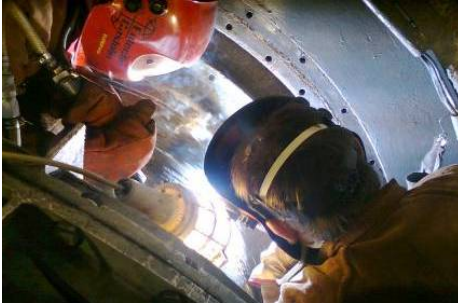
7c. izvođenje zavarivanja u ograničenom prostoru kapsule
