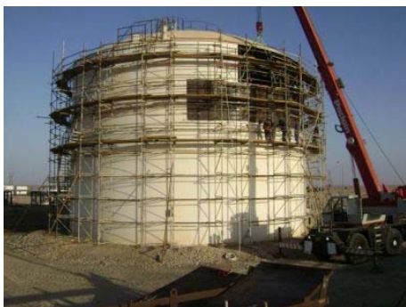
Slika 8. Primjer kompletne zamjene novim materijalom dva gornja prstena plašta
