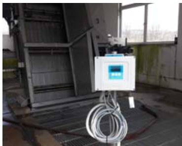
Slika 9. Pozicija ultrazvučnih mjerača protoka ispred i iza grube rešetke
