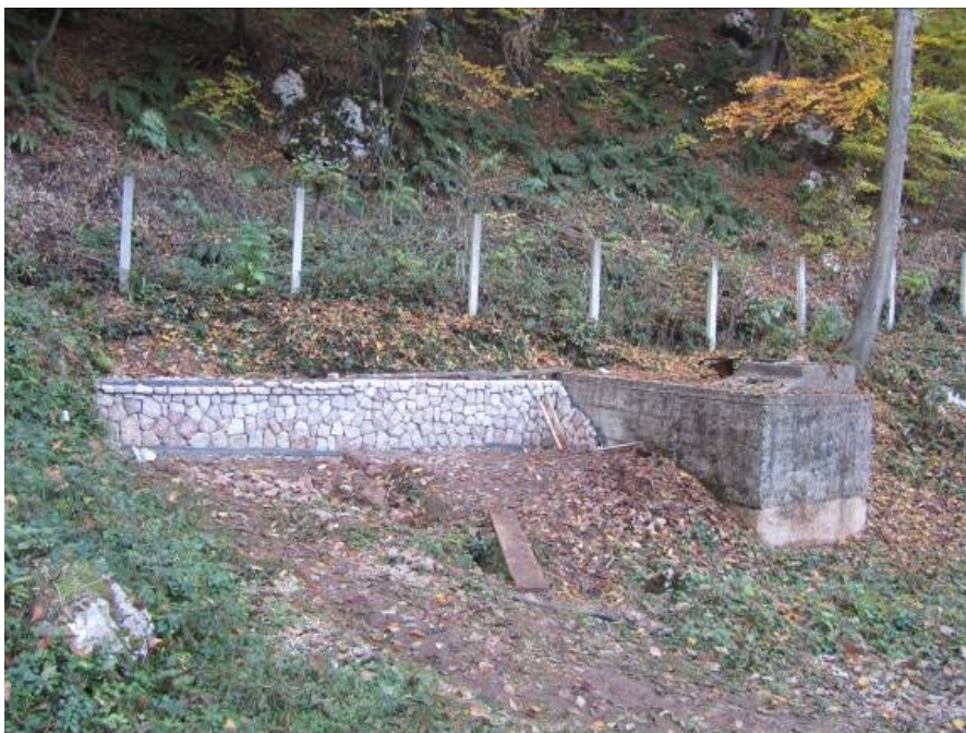
Slika 3. Adaptirana kaptaža na Crpnoj stanici „Vrela” , (septembar 2011.god.)
